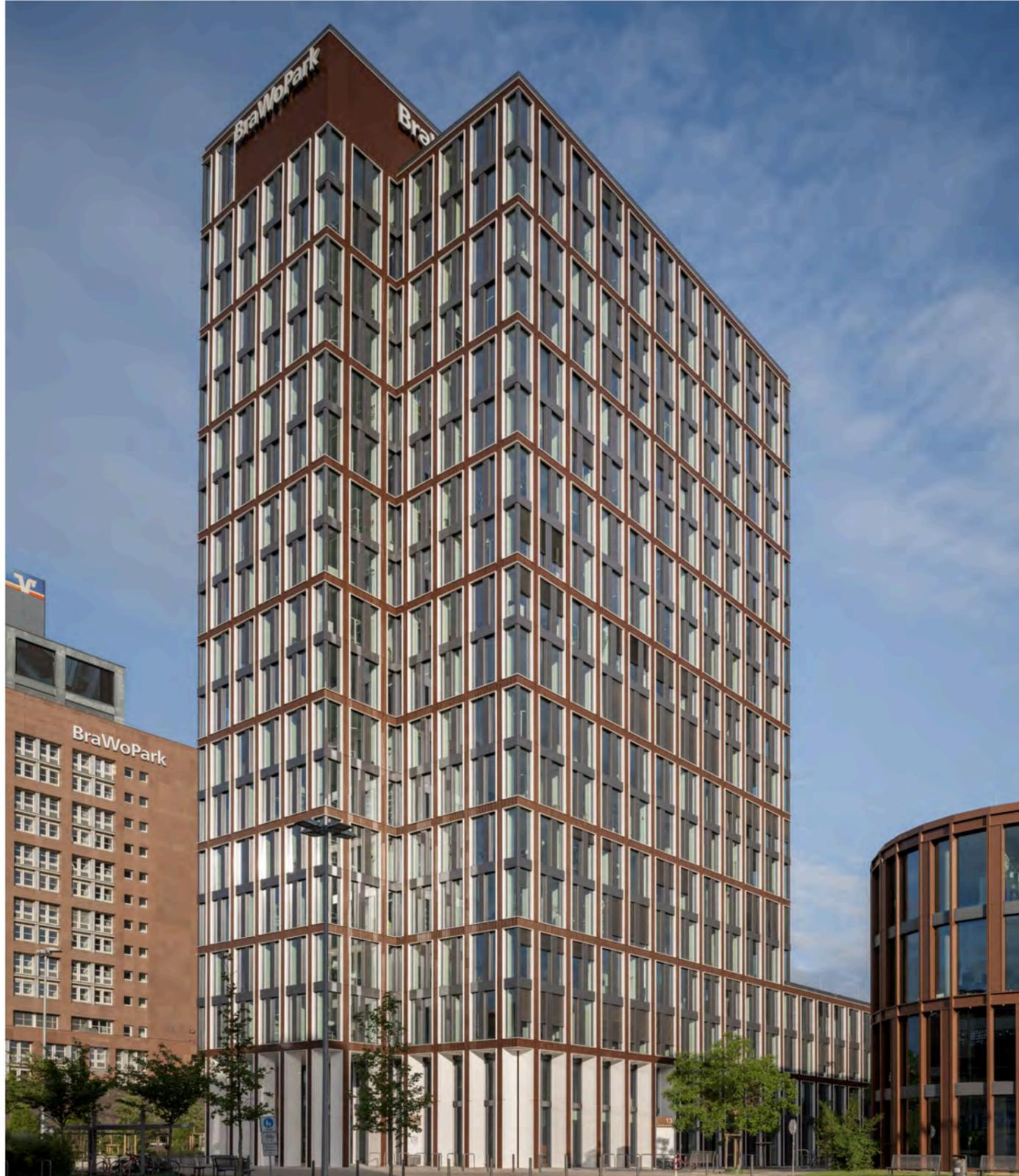
Vom Generalauftragnehmer, der Ed.Züblin AG, Direktion Nord - Bereich Niedersachsen erhielt die MEDICKE GmbH den Auftrag für die Planung, Produktion und Montage der Gebäudehülle. Der Büroturm erhielt eine Hülle aus Elementfassaden mit Systemen des Profilherstellers Schüco.
